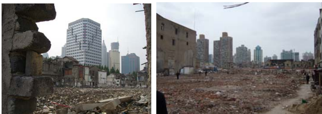
Terrains suite à des démolitions dans la perspective d'une opération immobilière, Shanghai, 2007
